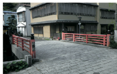
塗り替え前の柳橋
