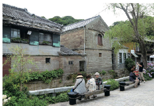
伊豆石を使用した建物
